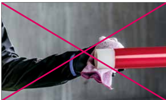
Fig. 03-24 Non usare stracci usati per la pulizia. Per detergere il tubo utilizzare solo stracci in fibra di cellulosa, puliti e resistenti all'acqua.
