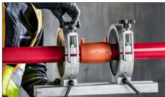
Fig. 03-12 Montare i morsetti universali per tubi universali. Controllare che il collegamento sia privo di tensione.
