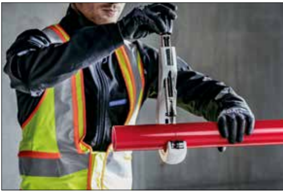
Fig. 03-1 Tagliare la misura desiderata. La superficie di taglio deve essere dritta, senza sbavature e perpendicolare rispetto all'asse del tubo.
