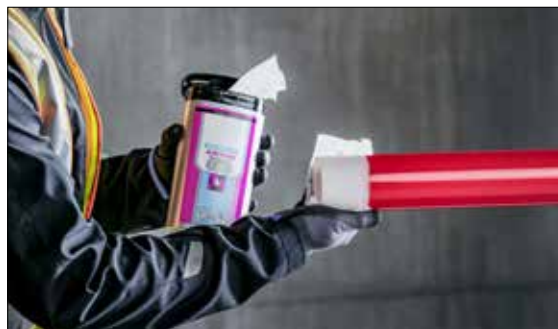
Fig. 03-8 L'area di raschiatura deve essere libera da polvere e grasso. Pulire sufficientemente con detergente Tangit e lasciarlo evaporare completamente.
