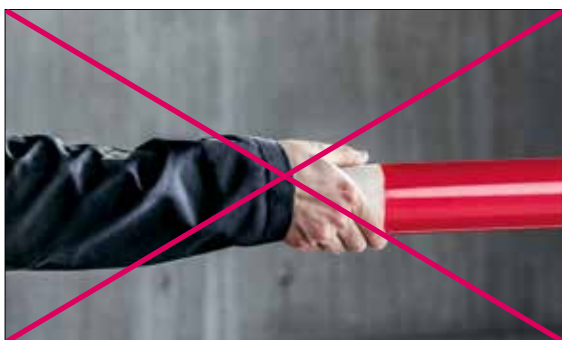
Fig. 03-26 Non toccare l'area da saldare della tubazione. Se necessario pulire di nuovo con l'apposito detergente Tangit le zone di saldatura.
