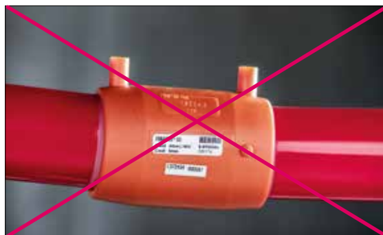
Fig. 03-29 Le estremità dei tubi devono essere allineate e non devono essere in tensione. Devono essere usati dei morsetti di fissaggio del tubo.
