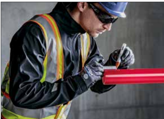
Fig. 03-2 Evidenziare l'area da raschiare secondo quanto riportato nella tab. 03-2.
