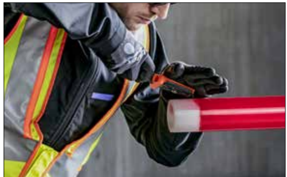
Fig. 03-38 Rimuovere i residui di rivestimento a colore con il raschietto manuale. La lama è perpendicolare rispetto al tubo e viene pressata con una mano durante il processo di raschiatura.
