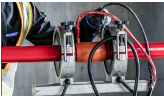
Fig. 03-13 Collegare l'apparecchio di saldatura SMARTFUSE, cavo rosso a contatto rosso. I parametri di saldatura vengono identificati automaticamente
