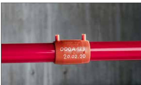
Fig. 03-20 La realizzazione del collegamento è completata.
