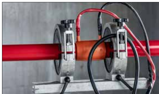
Fig. 03-14 Fissare il cavo di saldatura con un anello per evitare la rimozione involontaria.
