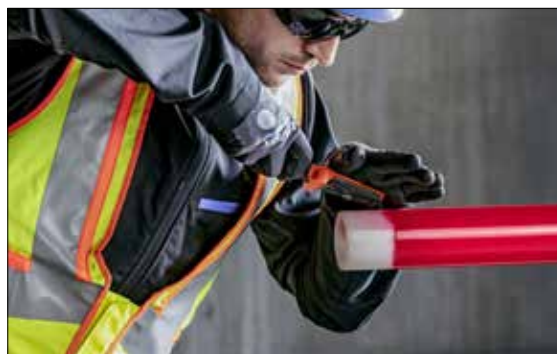
Fig. 03-5 Controllare l'intera area raschiata per vedere se c'è qualche residuo di colore. Tutti i residui di colore devono essere rimossi. Questo vale per tutti i tipi di tubi menzionati al punto 02.03.
