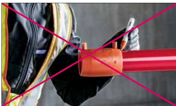
Fig. 03-22 Non utilizzare i manicotti per marcare il tubo.
