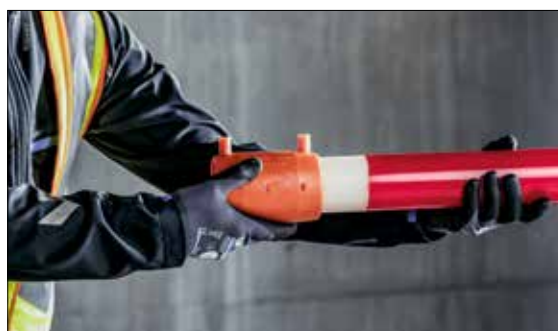
Fig. 03-10 Inserire fino al fermo il manicotto elettrosaldabile FUSAPEX sull'estremità del tubo.
