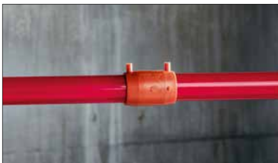
Fig. 03-11 Preparare la seconda estremità del tubo allo stesso modo e inserirla completamente.
