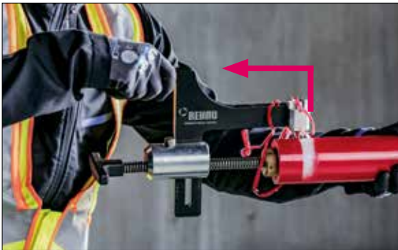
Fig. 03-35 SMARTFUSE UNO 63-200: Il processo di raschiatura termina all'estremità del tubo.
