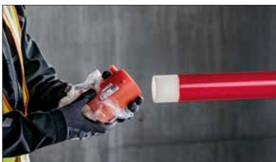
Fig. 03-9 Solo ora prendere il manicotto elettrosaldabile FUSAPEX dal sacchetto per la saldatura. Pulire se necessario il manicotto elettrosaldabile con l'apposito detergente Tangit.
