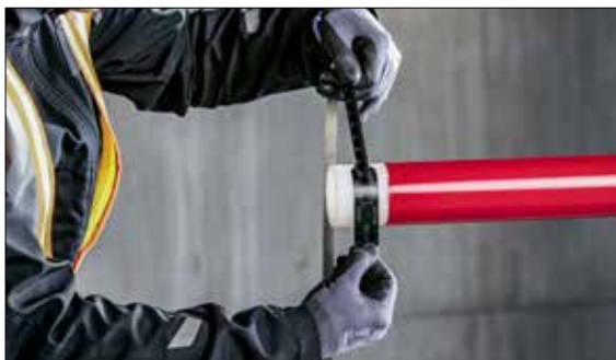
Fig. 03-7 Se necessario, controllare la circonferenza dell'estremità del tubo preparata per il collegamento con il nastro metrico.
