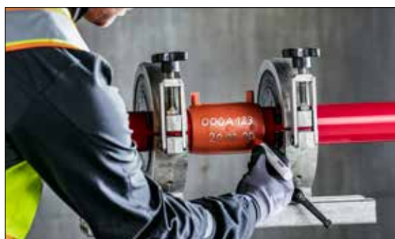
Fig. 03-18 Segnare in modo leggibile con una penna il numero d'identificazione personale e la data del giorno sul manicotto elettrosaldabile.
