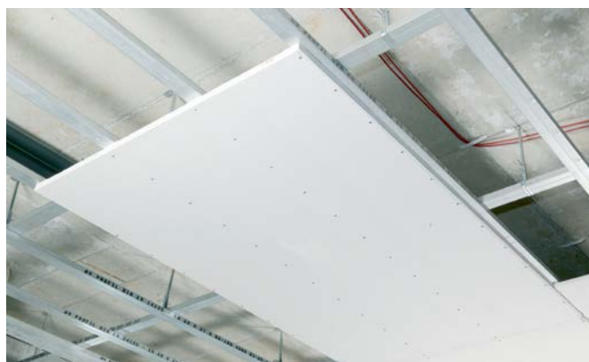
Rys. 6-11 Zamontowana płyta sufitowa
