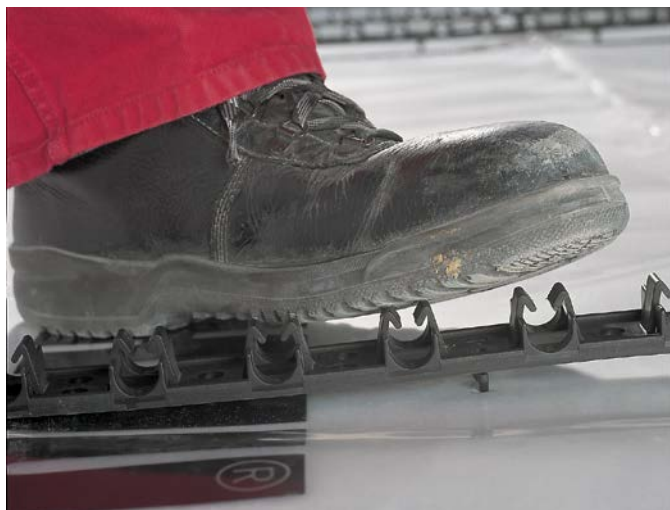
Rys. 4-122 Wcisnięcie listwy RAUFIX w konstrukcję podłogi
