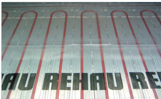
Rys. 4-149 System suchej zabudowy TS-14
