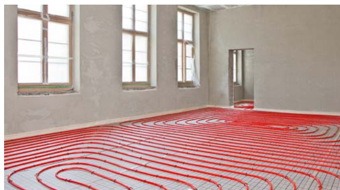
Rys. 4-71 Płyta systemowa Tacker
