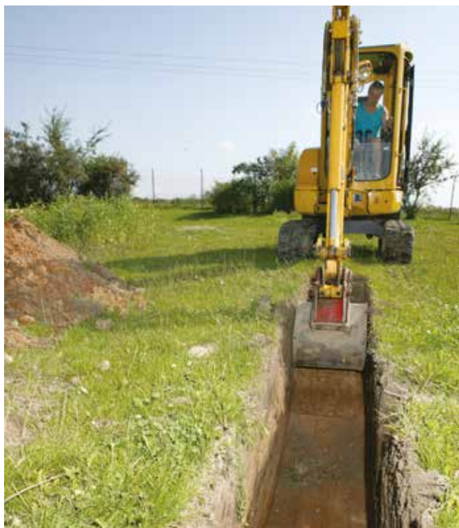
Fig. 3-39 Travaux de terrassement.
