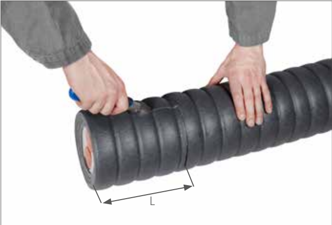
Fig. 2-18 Longueur tube à dénuder pour installation kit étagé RAUVITHERM ou RAUTHERMEX.
