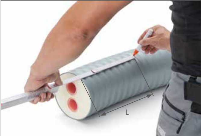
Fig. 2-19 Longueur tube à dénuder pour installation kit à clipser RAUTHERMEX.
