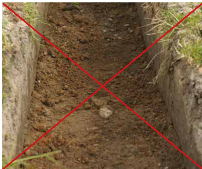
Fig. 3-40 Fond de tranchée.
