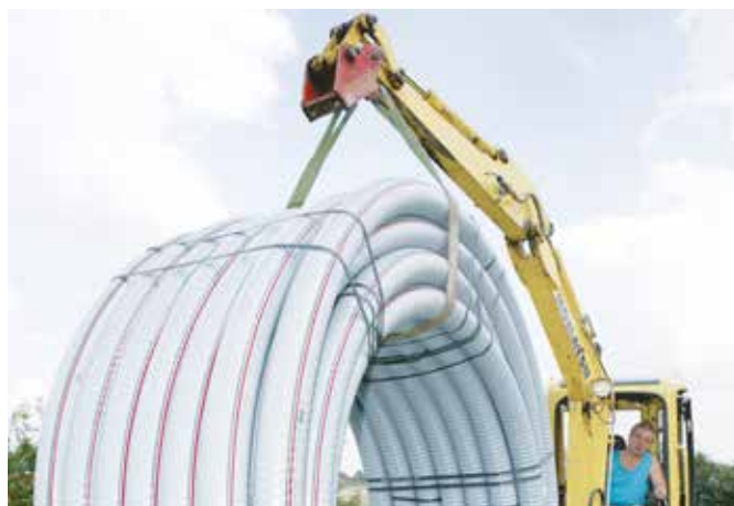
Fig. 3-24 Préhension avec pelle excavatrice.
