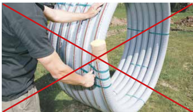
Fig. 3-28 Mise en œuvre interdite.
