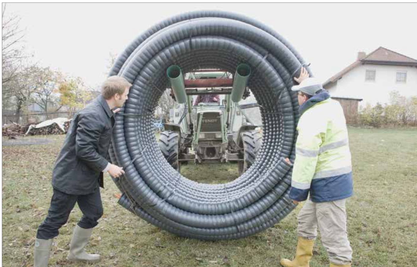
Fig. 3-21 Mise en œuvre.
