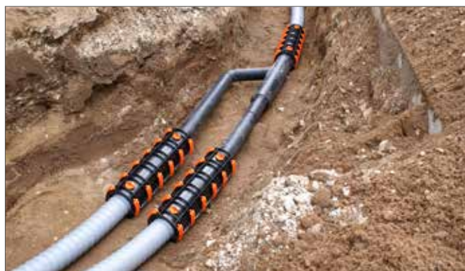
Fig. 3-56 Dérivation Y en tranchée.
