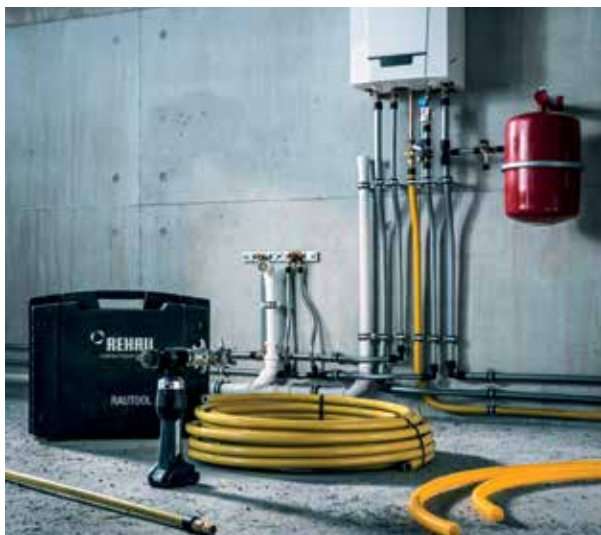
Impianto sanitario con pompa dosatrice RE.DOS installata.
