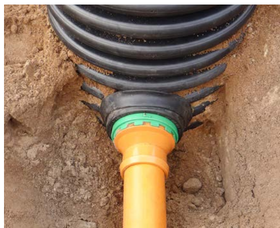
Collegamento della ventilazione alla prolunga tramite AWADOCK
