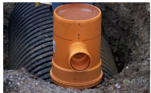
Bocchettone di collegamento innestato
