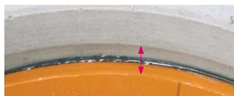
Distanza cono-anello di supporto in calcestruzzo
