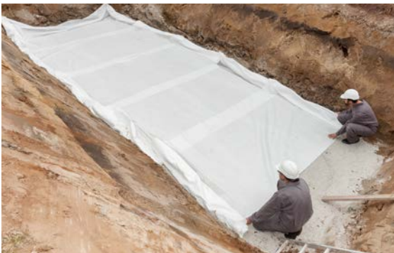
Fossa con telo posato
