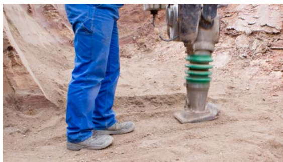
Preparazione del terreno
