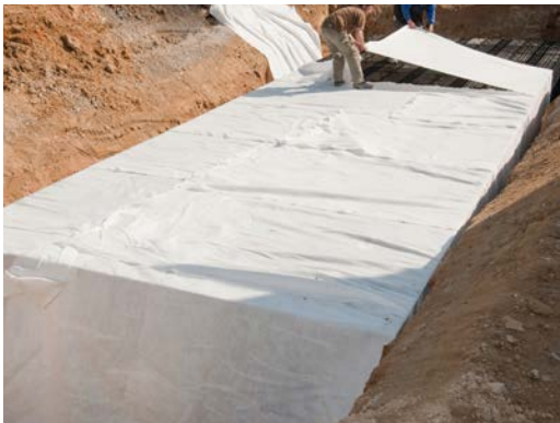
Bacino a elementi modulari RAUSIKKO con filtro geotessile in tessuto non tessuto RAUMAT
