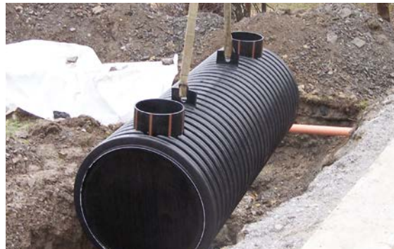
Posa della linea di sedimentazione nella trincea per tubi
