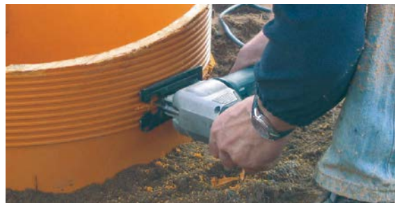
Riduzione del cono per pozzetto
