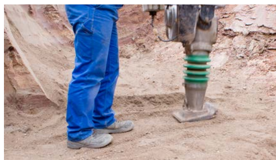
Preparazione del terreno
