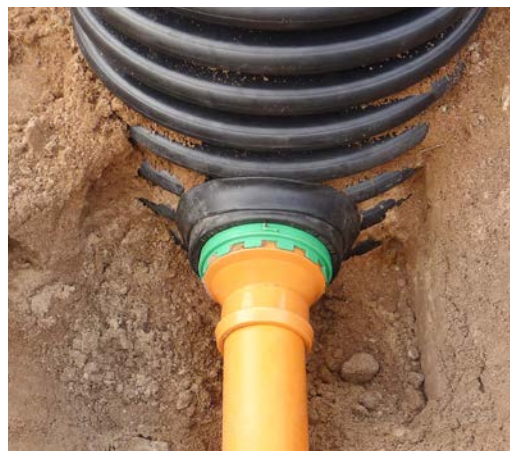
Collegamento della ventilazione alla prolunga tramite AWADOCK
