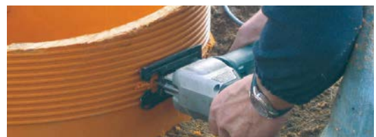
Riduzione del cono per pozzetto
