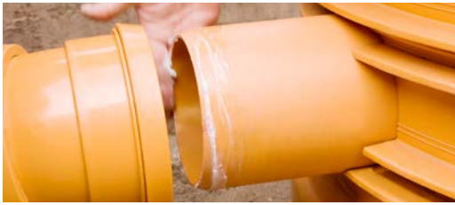
Applicazione del lubrificante
