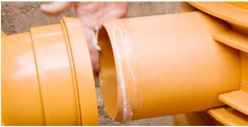
Applicazione del lubrificante
