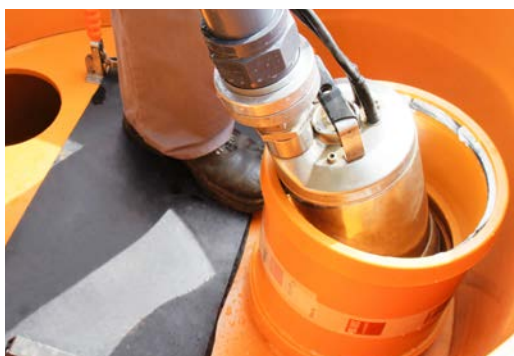
Introduzione della pompa nella camera di afflusso
