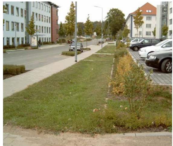
Cunetta di drenaggio di una bacino con cunetta, in seguito alla realizzazione
