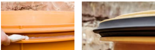
Applicazione del lubrificante Anello di tenuta inserito
