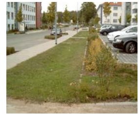
Cunetta di drenaggio di un bacino con cunetta, in seguito alla realizzazione
