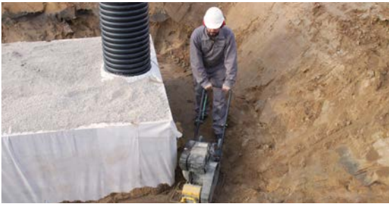
Compattamento dell'area di lavoro
