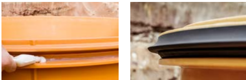
Applicazione del lubrificante Anello di tenuta inserito
