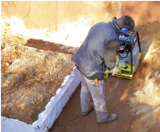
Compattamento dell'area di lavoro
