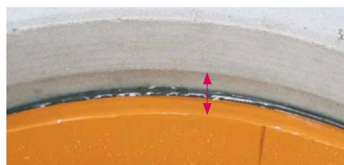
Distanza cono-anello di supporto in calcestruzzo
