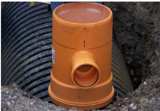
Bocchettone di collegamento innestato
