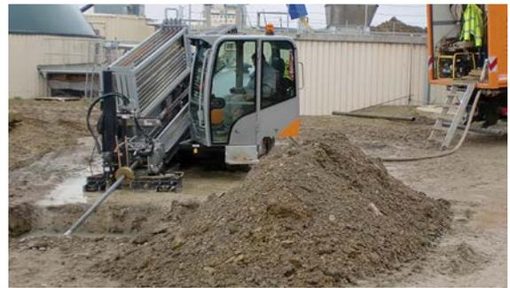
Abb. 07-10 Verlegung mit Spülbohrgerät
