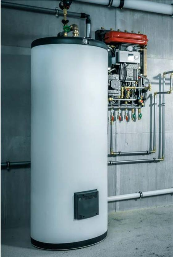
Abb. 06-9 Dezentraler Wärmespeicher
