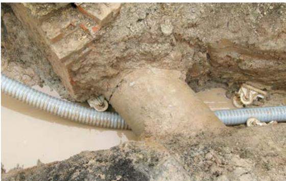
Abb. 07-24 Einfache Verlegung durch flexible Leitungsführung
