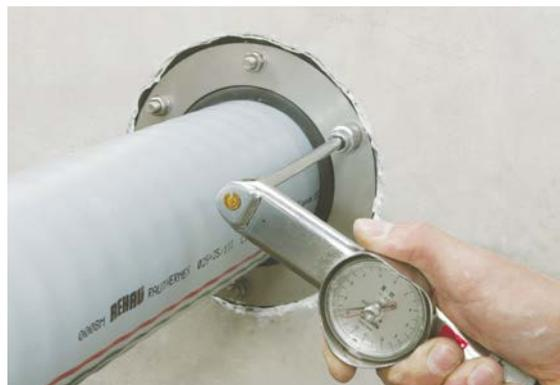
Abb. 05-12 Montage mit Drehmomentschlüssel
