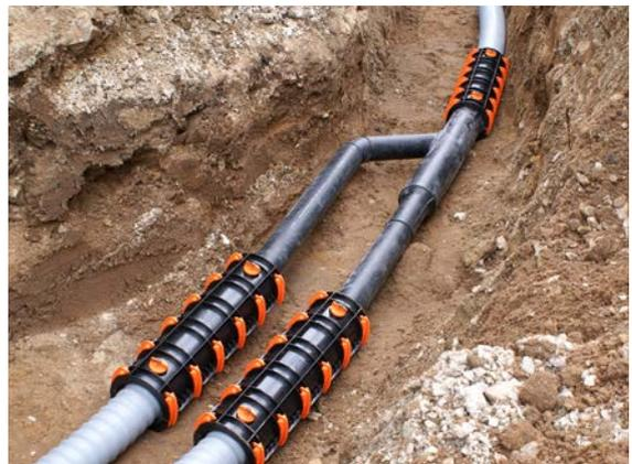
Abb. 04-34 Hosenrohrinstallation in der Praxis
