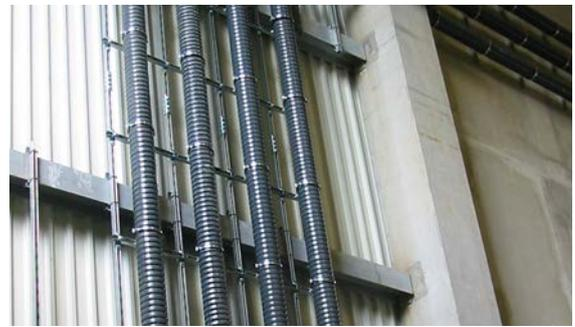
Abb. 07-29 Beispiel Freiverlegung/Wandmontage
