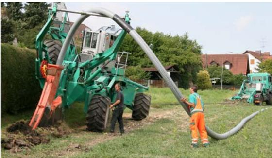
Abb. 07-8 Verlegung mit Rohrflug
