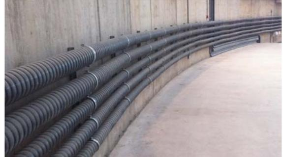
Abb. 07-28 Beispiel Freiverlegung/Wandmontage
