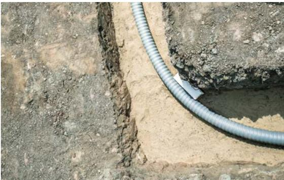
Abb. 07-23 Richtungsänderung ohne Formteile
