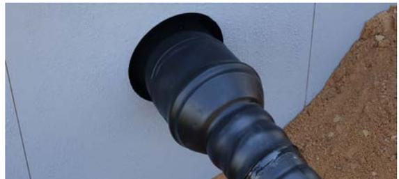
Abb. 05-16 Montagebeispiel Hauseinführungsset mit Schrumpfschlauch und Gliederkettendichtung
