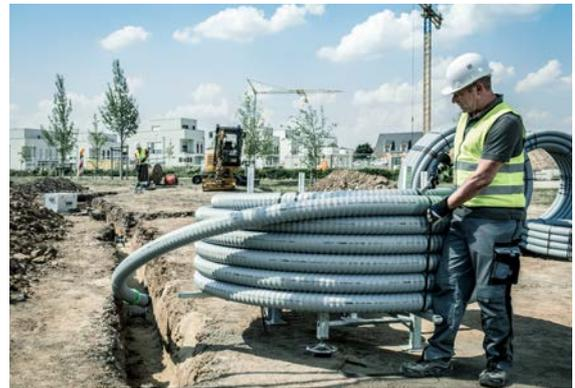
Abb. 07-34 Stationäre horizontale Abwickelvorrichtung am Grabenende
