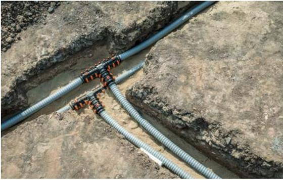
Abb. 07-4 Verlegung in offener Bauweise
