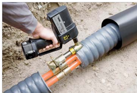
Unión mediante casquillo corredizo
