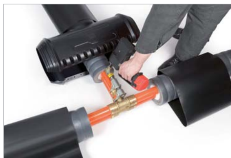
Instalación de manguito en T RAUVITHERM
