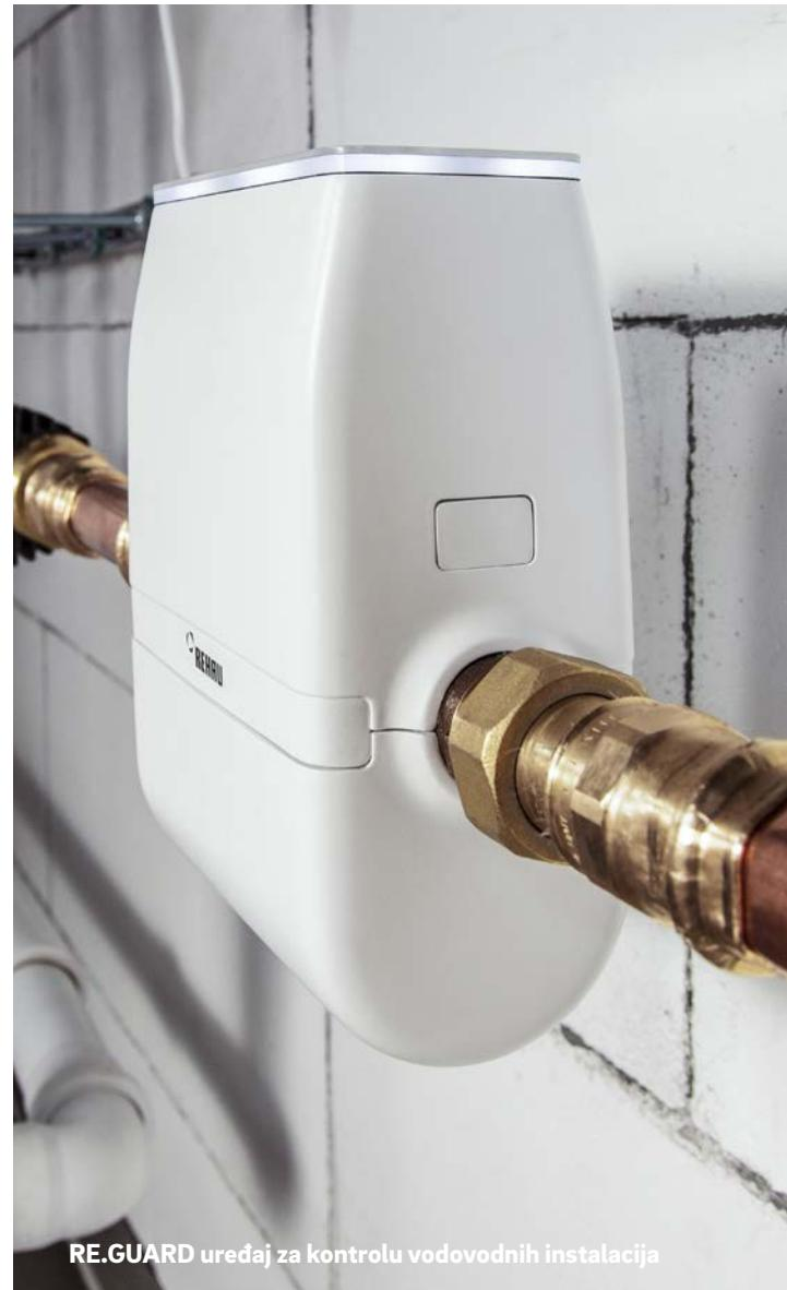
**RE.GUARD uređaj za kontrolu vodovodnih instalacija**
