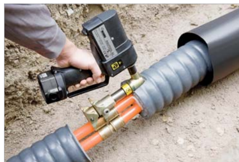
Unión mediante casquillo corredizo
