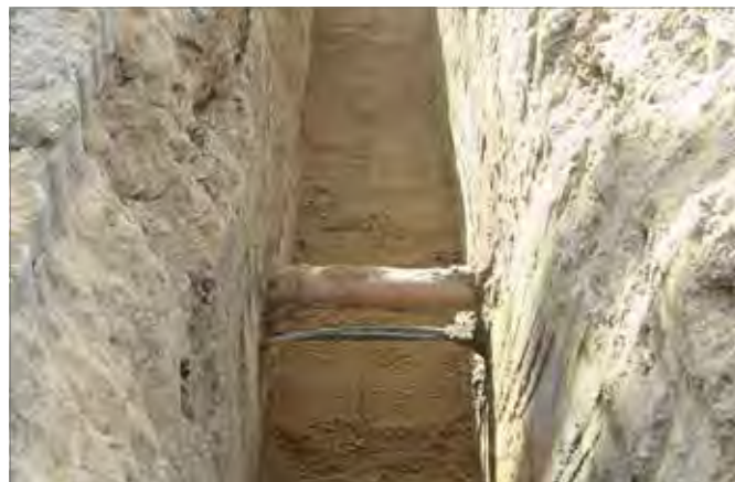
Rys. 7-2 Dno wykopu z podłożem pod rury
