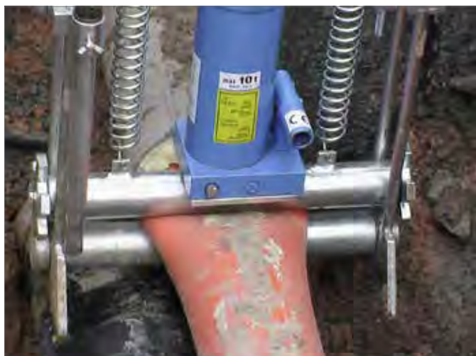
Rys. 7-26 Zaciskanie rury medialnej pojedynczej UNO
