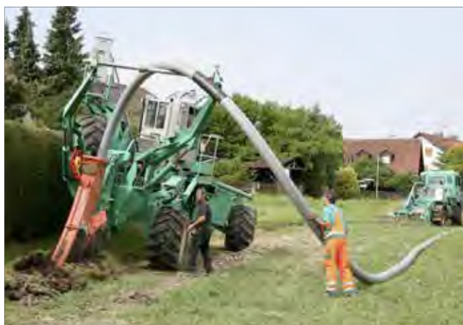
Rys. 7-8 Układanie przy pomocy plugu
