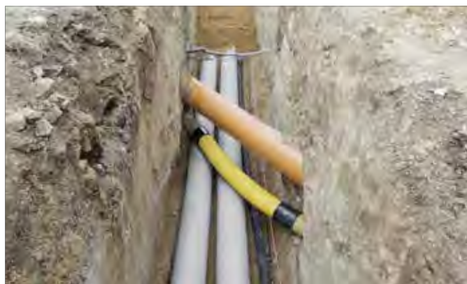
Rys. 7-19 Przejście pod przewodami przecinającymi trasę
