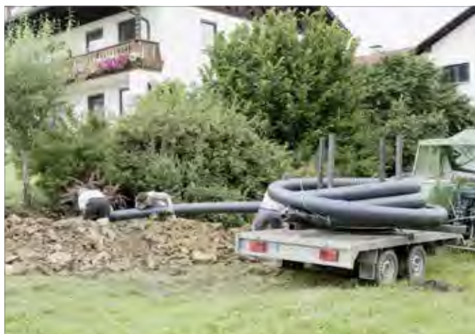
Rys. 7-28 Kołowrót do odwijania rur w poziomie umieszczony na przyczepie
