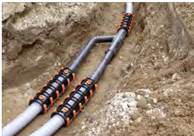
Rys. 4-25 Sposób zainstalowania trójnika rurowego równoległego w praktyce
