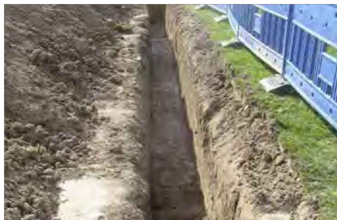
Rys. 7-1 Odpowiednio wykonane dno wykopu
