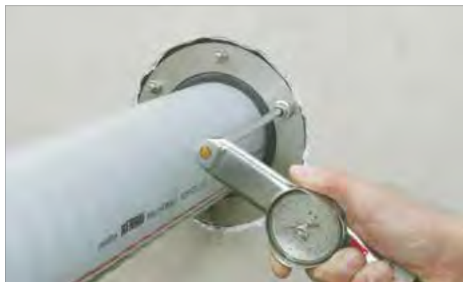
Rys. 5-14 Montaż przy użyciu klucza dynamometrycznego
