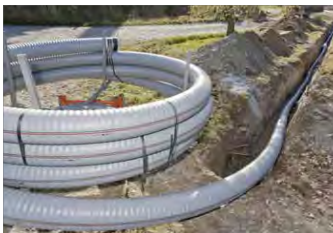
Rys. 7-29 Stacjonarny kołowrót do odwijania rur w poziomie umieszczony na końcu wykopu
