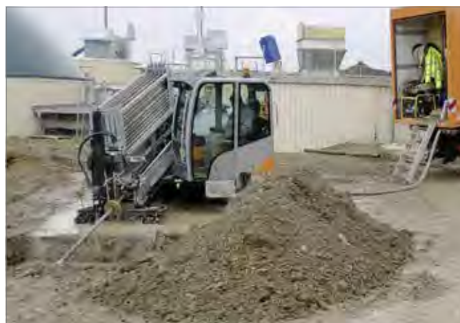
Rys. 7-10 Układanie przy pomocy wiertnicy
