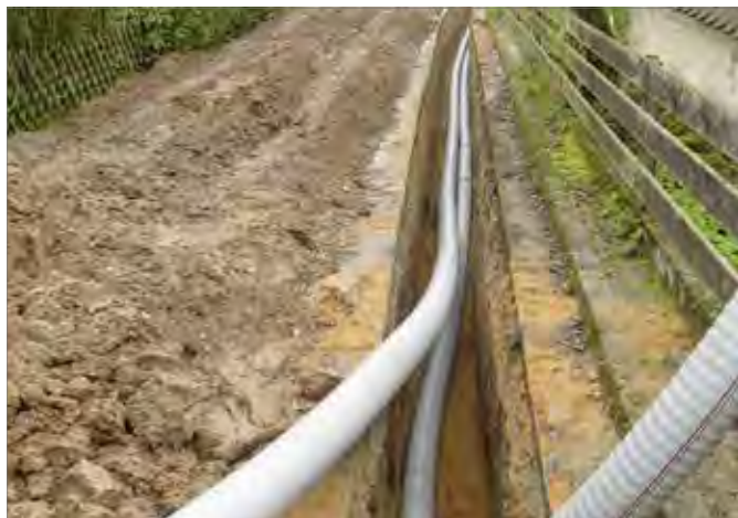
Rys. 7-4 Układanie w wykopach otwartych
