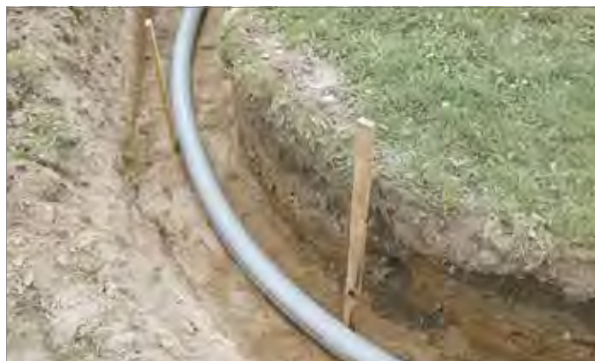
Rys. 7-20 Zmiana kierunku przebiegu rury bez użycia kształtek
