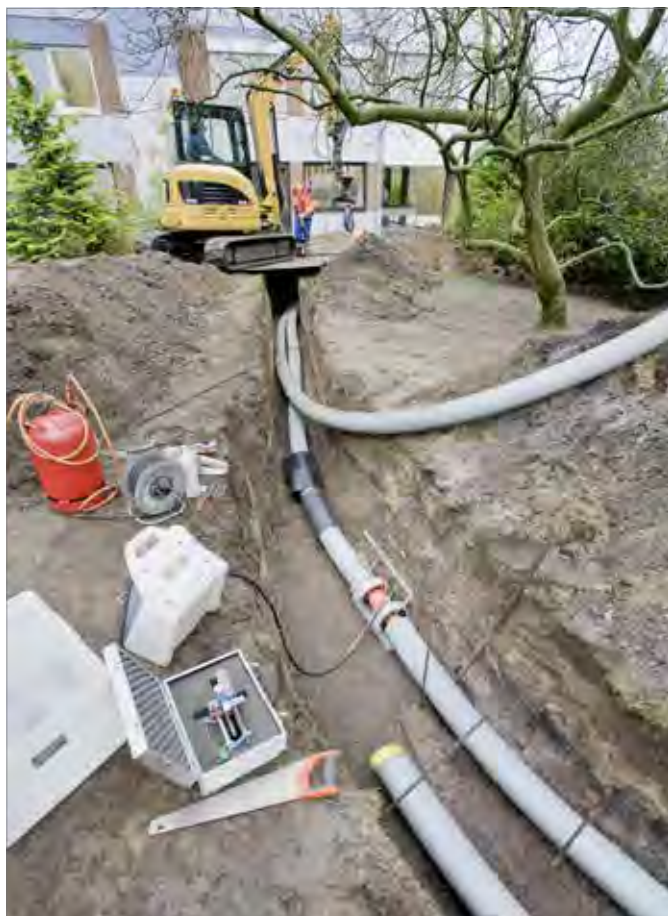
Rys. 4-11 Połączenie zgrzewane metodą FUSAPEX w praktyce
