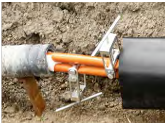
Rys. 7-27 Zaciskanie rury medialnej podwójnej DUO
