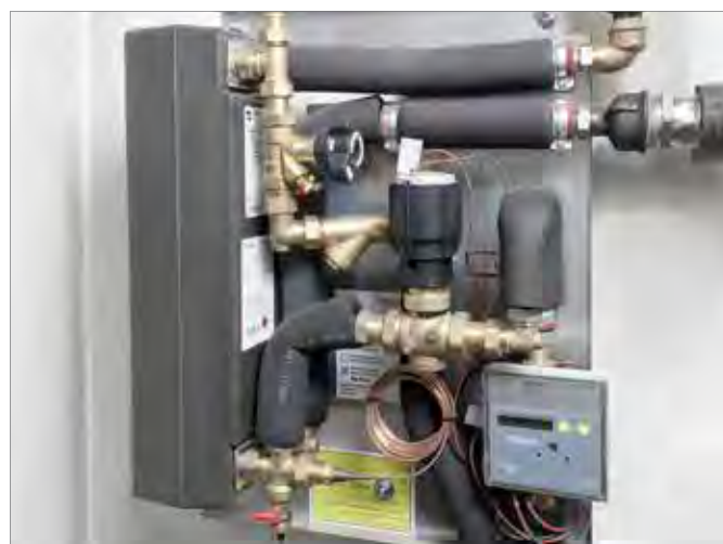
Rys. 5-2 Wymiennik ciepła
